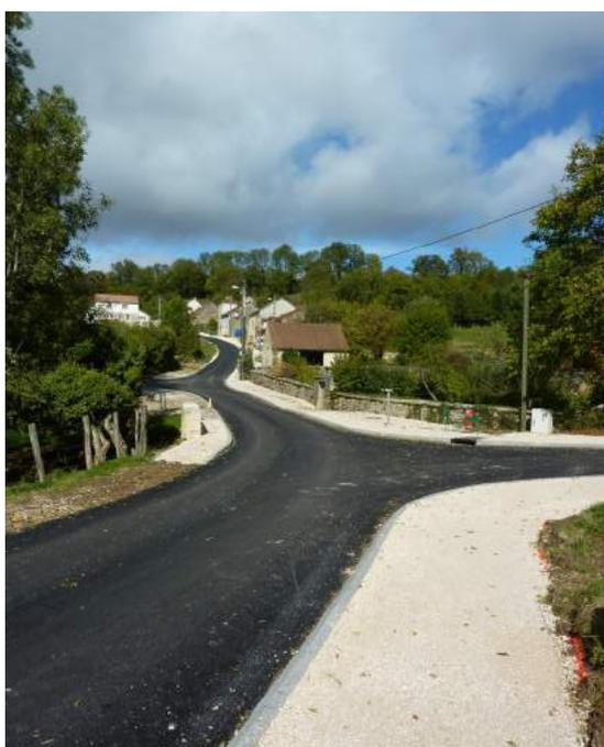
Dans la continuité des travaux de voirie de la partie haute de la Villotte et après les travaux relatifs à la station d'épuration, il est actuellement procédé à la reprise de la chaussée jusqu'à la RD 905. La partie basse sera réalisée en bicouche, la partie pentue haute en enrobé.
